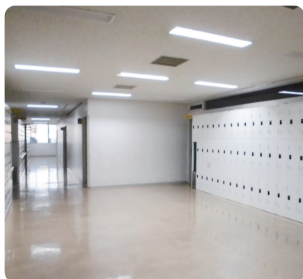
立教池袋中高 LED照明器具更新
