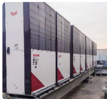
新座中学校・高等学校 空調設備更新
