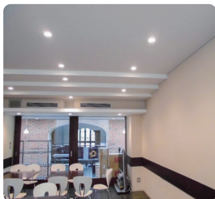
立教大学池袋キャンパス (第一食堂) LED照明器具更新
