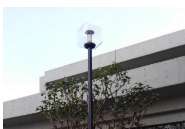
立教新座中学校・ 高等学校 外灯 照明器具更新
