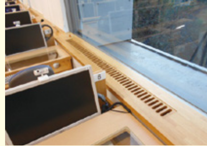
立教大学新座キャンパス 8号館 教室窓下の自然換気口(2011年)
