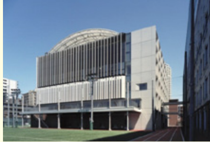
ポール・ラッシュ・アスレチックセンター 西面の日射除けルーバー(2013年)
